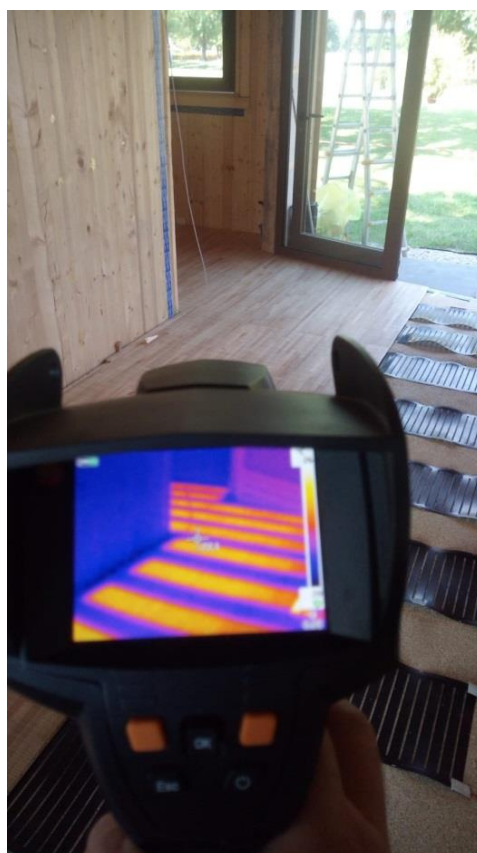
System PAD FIR Indoor Tappeto Radiante elettrico 36 Volt DC a Raggi Infrarossi Lontani. Tecnologia dei semiconduttori in PTC polimerico a vibrazione molecolare (coefficiente di temperatura positivo) Lunghezza d'onda 8-10 \mu\text{m}
